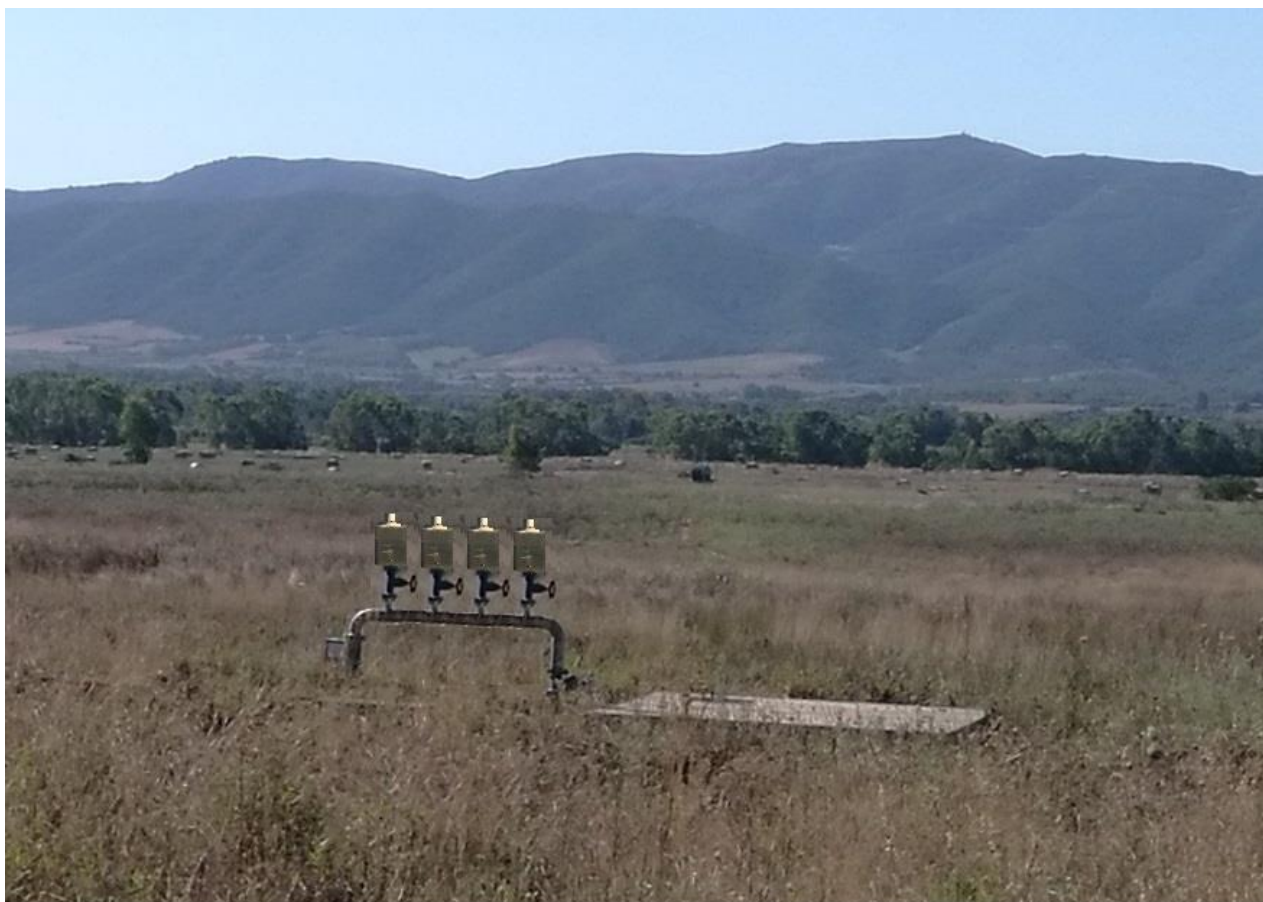
Figura 17 – Situazione post - intervento: Pozzetto su linea interrata e opera di consegna alle utenze fuori terra.
